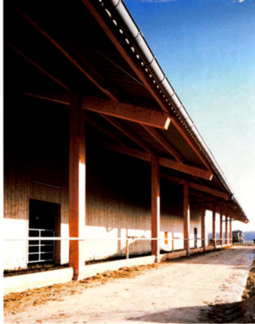
Das weit überkragende Dach in Schöna dient u.a. dem konstruktiven Holzschutz
